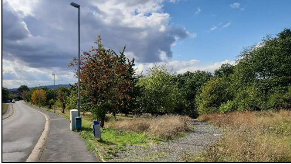
Abb. 14: Trassenbeginn am Braunfelser Weg
