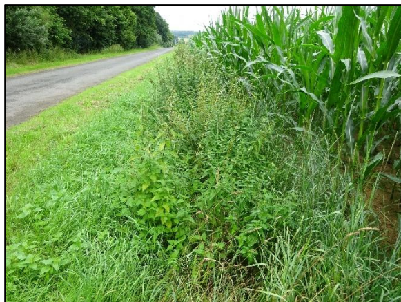
Abb. 18: Asphaltierter Weg mit Seitenstreifen und Entwässerungsmulde (eigene Aufnahme 07/2021).
