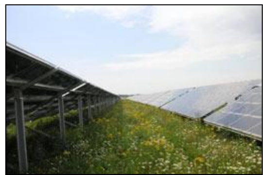
Abb. 24: Beispiel „Aufgeständertes Modulfeld“
