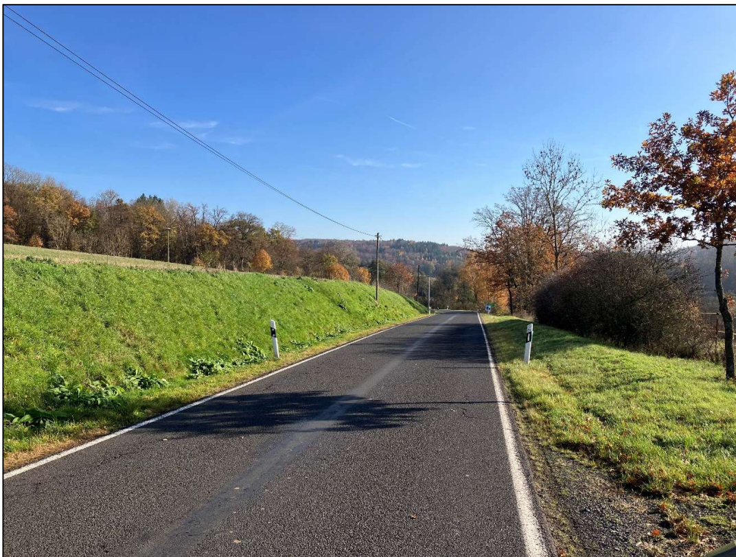
Abb. 35: Blick vom Beobachtungspunkt 2 in Richtung des Hofguts. Das Hofgut ist am Ende der Straße stark eingeschränkt sichtbar.
