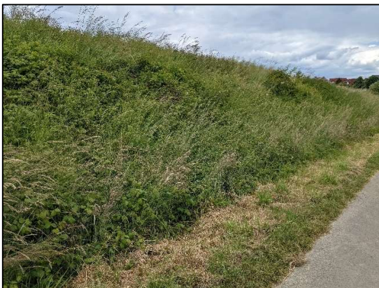
Abb. 12: Böschung im nördlichen Randbereich des Plangebietes (06/2024)
