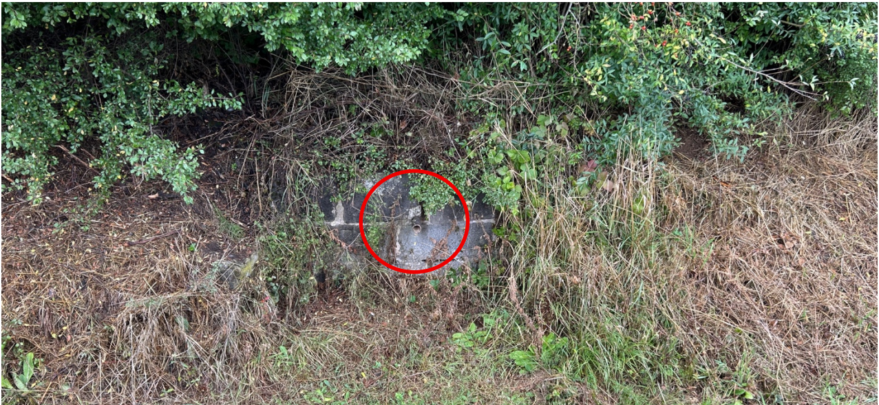
Abbildung 4: Entwässerungsbauwerk im Bereich von BP 12.
